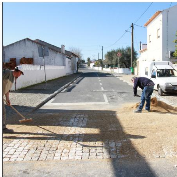
Sabugueiro - Calçamento de passadeiras elevadas
