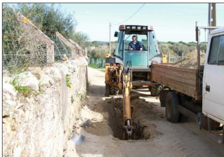
Igrejinha - Reformulação da rede de esgotos
