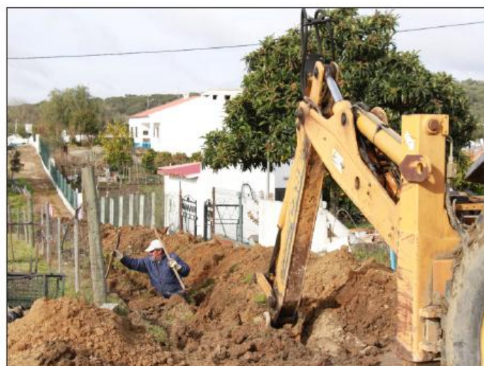
Vale do Pereiro - Desvio de águas pluviais
