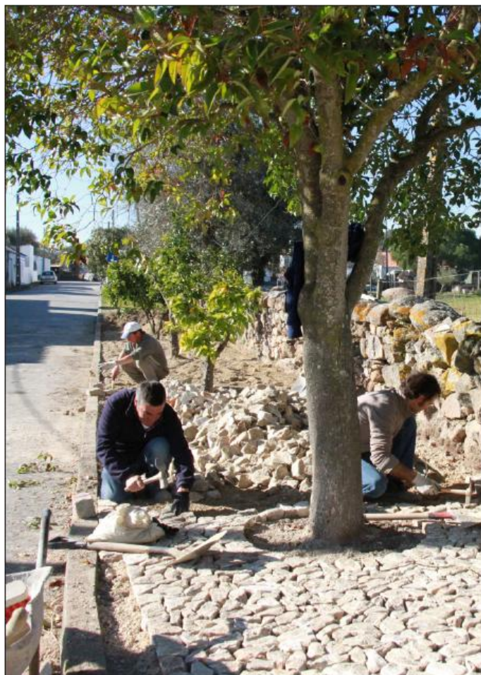
Sabugueiro - Calçamento de passeio
