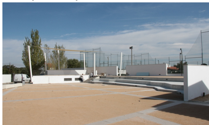
Remodelação Largo de Santa Clara - Sabugueiro
