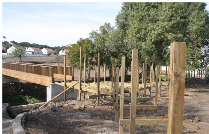
Construção de Passadiço e Ponte Ribeira de Vide - S. Pedro da Gaf.
