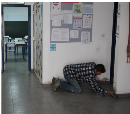
Colocação de piso -
