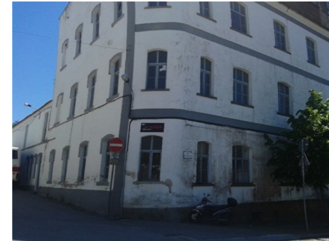
174 | Edifício a reabilitar
