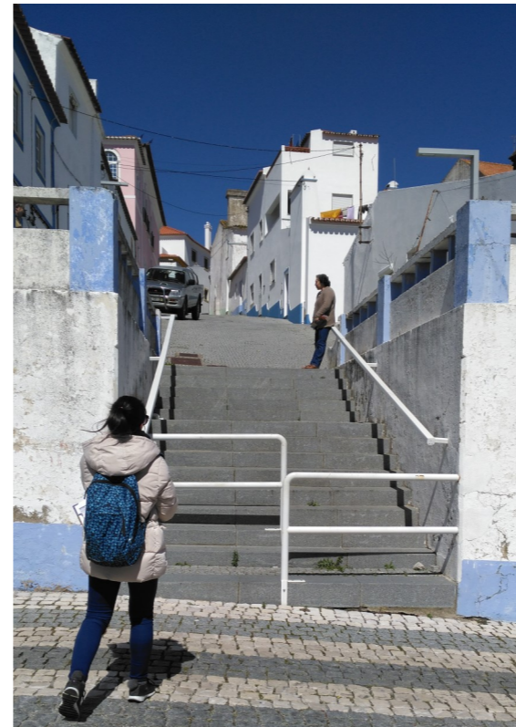
145 | Escadas de acesso ao Largo
