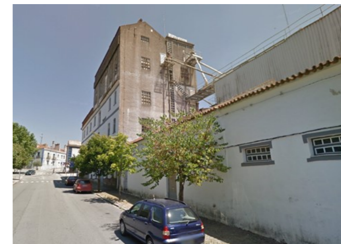
175 | Edifício a reabilitar
