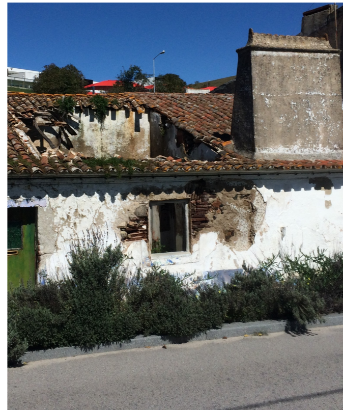
86 | Edifício sem caixilharia
