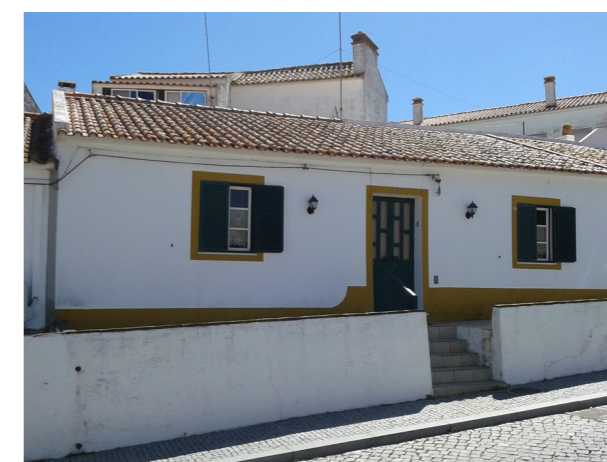
59 | Edifício de habitação
