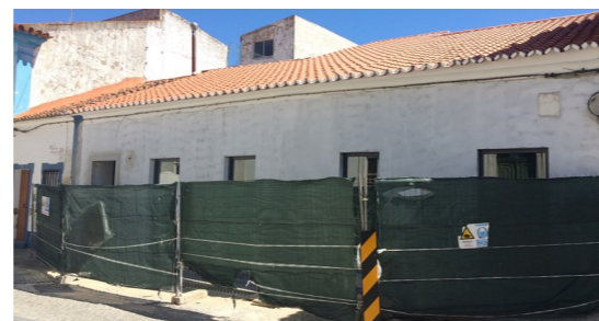
68 | Exemplo de edifício em Obras
