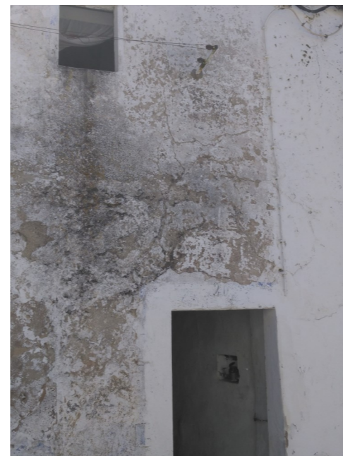
80 | Desagregação de reboco
