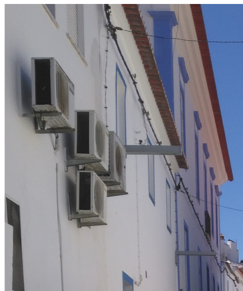
82 | Presença de máquinas de AC
